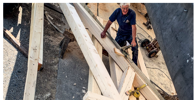
La structure du toit en préassemblage
